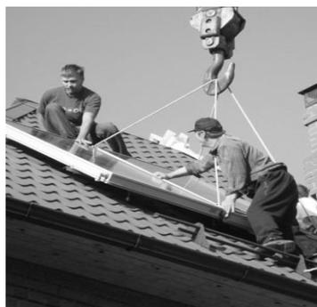
**Рисунок 3 -** Монтаж солнечного коллектора
